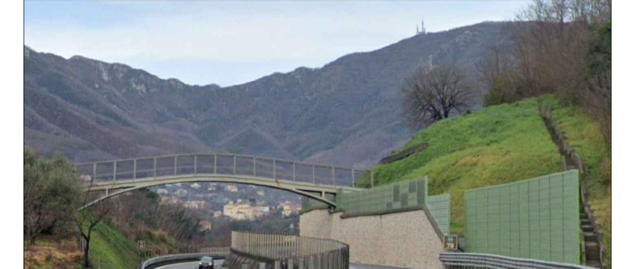
intervento di revisione e sistemazione delle opere nelle zone limitrofe alla passerella Opera 313
